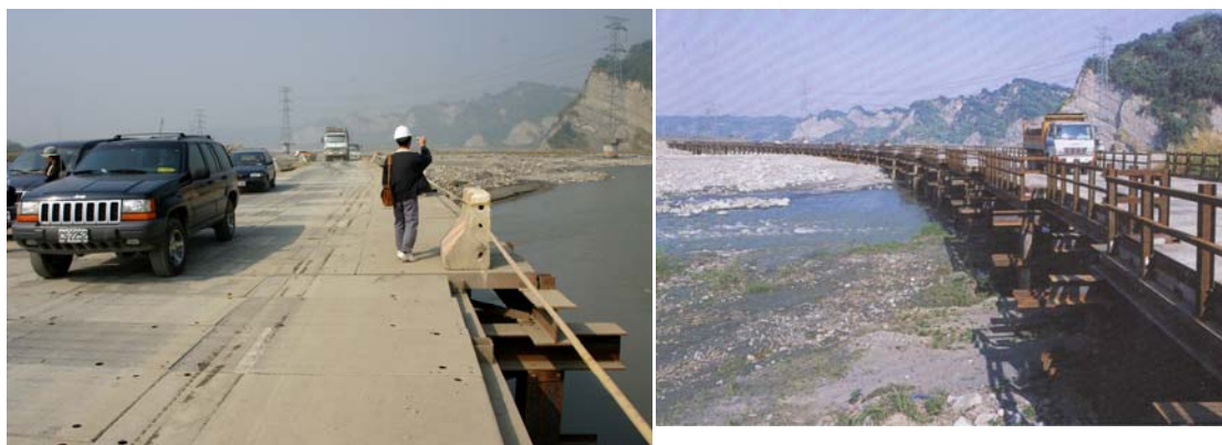
X601 標鋼棧橋跨烏溪主流降低水域干擾 X601 標鋼棧橋跨烏溪主流全景
