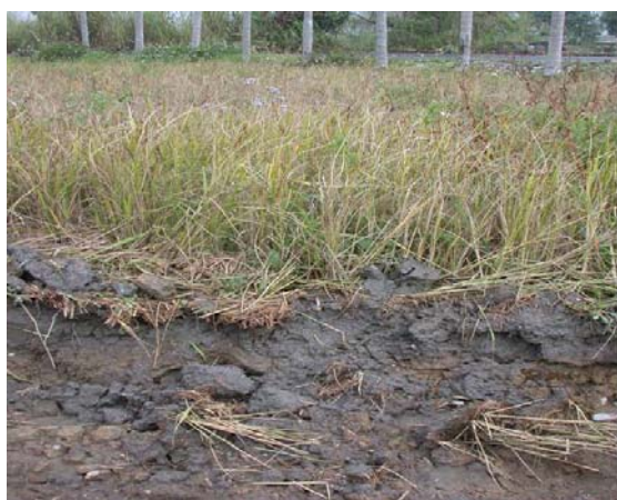
清除掘除區肥沃的田土
